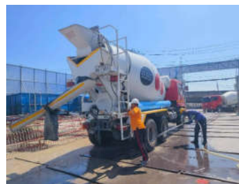
งานฉีดล้างล้อรถก่อนออกจากไซต์
