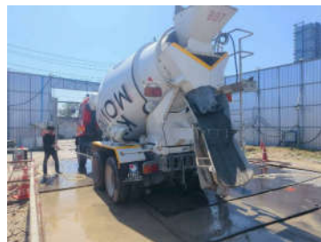
งานฉีดล้างล้อรถก่อนออกจากไซต์
