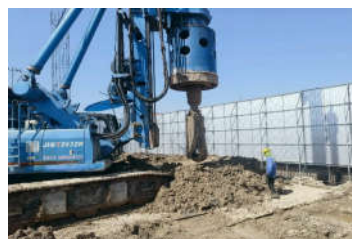
งานเจาะเสาเข็มดิน PC4,PA5
