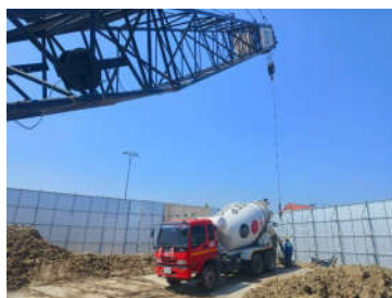
งานเทคอนกรีตเสาเข็มดิน PC4,PA5
